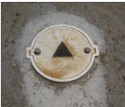
Otros pozos de monitoreo en el Patio de Tanques tienen tapas al nivel del suelo, como la que aparece en la foto.
