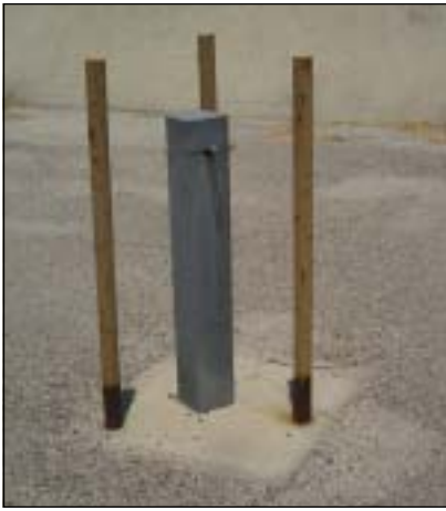
Algunos pozos de monitoreo ubicados dentro del Patio de Tanques tienen tapas ubicadas por encima del suelo.
